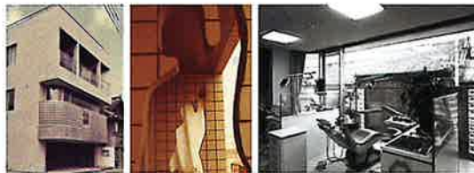
□歯科*1 昭和53年竣工。白杉の隣町、JR津久見駅前。間口が狭く奥に長いコの字町家プラン。周りの瓦屋根と調和させる色調と素材を配慮。ピラーをスーパーマンが通り抜けたような穴がある。(RC 3階建528m 2 )
