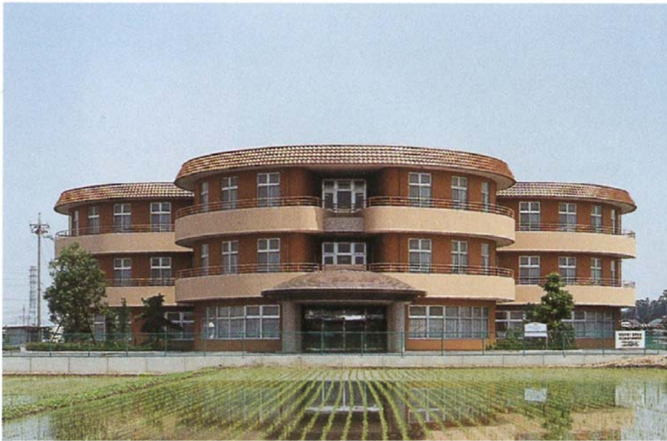
ファサード 3つのグループホームを表現した型の外観
