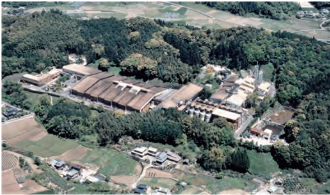
山に囲まれた大分醤油協業組合工場 俯瞰 右奥から原料処理、仕込み、発酵醸造樽群、左 製品工程、出荷事務棟 右手前は山の谷を利用の排水処理施設
