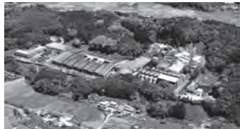
山に囲まれた大分醤油協業組合工場 俯瞰 右奥から原料処理、仕込み、発酵醸造樽群、左 製品工程、出荷事務棟 右手前は山の谷を利用の排水処理施設
