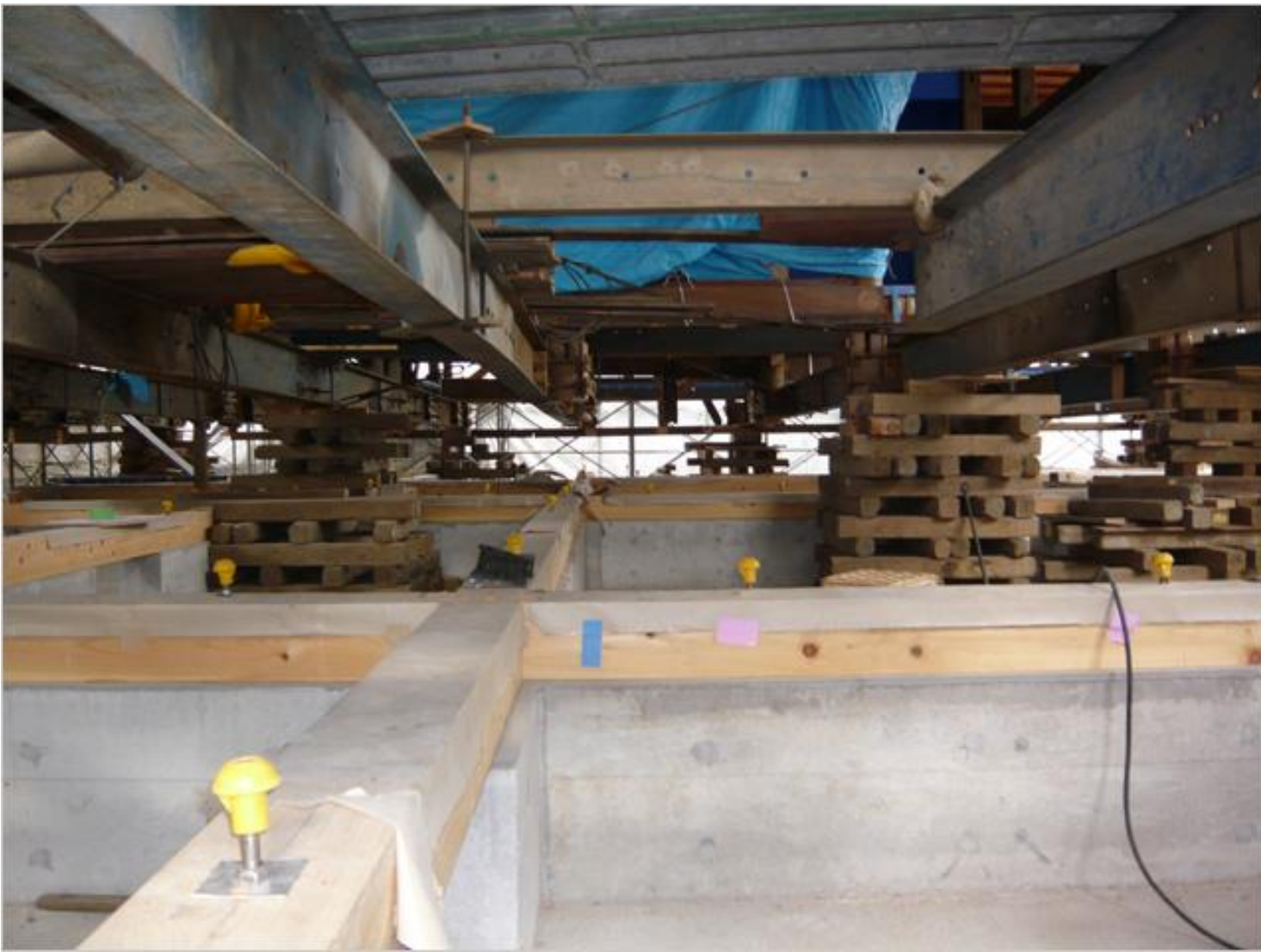
<写真2：ジャッキアップと曳家で新たな高基礎をつくる（天野彰撮影）>
